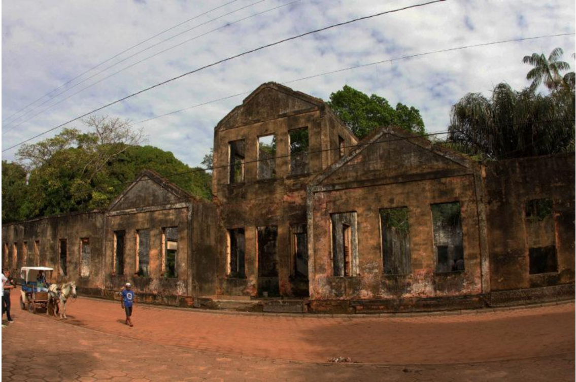
Fotografia 7 - Ruínas do antigo educandário Nogueira de Farias
